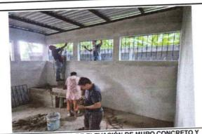
FOTO 10: EN PROCESO DE ELEVACIÓN DE MURO CONCRETO Y COLOCACIÓN DE BALCONES DE METAL.
