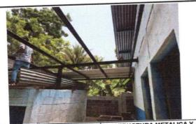
FOTO 11: EN PROCESO DE COLOCACIÓN ESTRUCTURA METALICA Y LAMINA.
