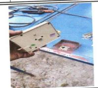
FOTO 2: EN PROCESO DE COLOCANDO CHAPAS NUEVAS A PUERTAS.
