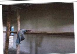
FOTO 3: EN PROCESO DE REPELLO DE PAREDES EN COCINA.
