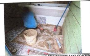
FOTO 5: EN PROCESO DE SUSTITUCIÓN DE INODOROS Y COLOCACIÓN DE PISOS Y AZULEJOS EN PAREDES DE BAÑOS.
