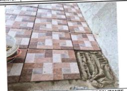
FOTO 7: EN PROCESO DE COLOCACIÓN PISO ANTIDESLIZANTE.
