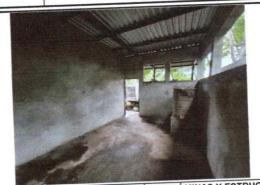
FOTO 8: EN PROCESO DE COLOCACIÓN DE LÁMINAS Y ESTRUCTURA DE SOPORTE DE METAL.
