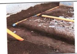
FOTO 6: EN PROCESO DE CAMBIO DE TUBERIA DE AGUAS NEGRAS.
