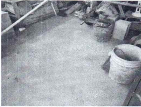
FOTO 7: SE OBSERVA EL PISO RÚSTICO DE CEMENTO.
