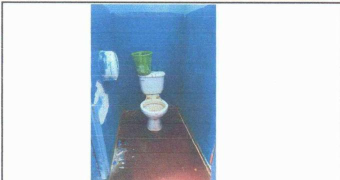
Foto 3: Se observan los sanitarios en mal estado, por tal motivo necesitan sustitución.
