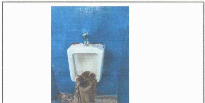
Foto 6: Los migitorios se encuentran en mal estado y por ahorrar espacio se sustituirán por unos de concreto y azulejo
