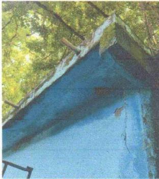
Foto 9: La losa cuenta con filtraciones de agua por tal motivo debe de se impermeabilizada
