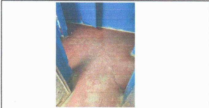
Foto 1: Se observa deterioro y grietas en el piso de los módulos de los servicios sanitarios
