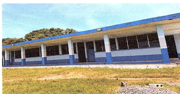
Foto 9: SE OBSERVA QUE LOS MUROS DEL MÓDULO DE AULAS 1 YA RECIBIERON SU MANTENIMIENTO PREVENTIVO.
