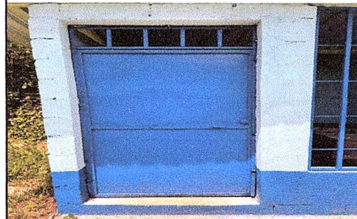
Foto 6: SE OBSERVA QUE LS PUERTA FUE SUSTITUIDA POR UNA DE METAL.
