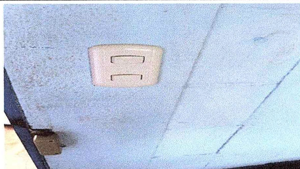
Foto 8: SE OBSERVA QUE LOS ELEMENTOS DEL SISTEMA ELECTRICO FUERON SUSTITUIDOS.
