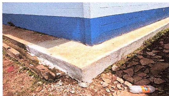
Foto 10: SE OBSERVA QUE BANQUETA DEL MÓDULO 2, YA FUE REPARADA.
