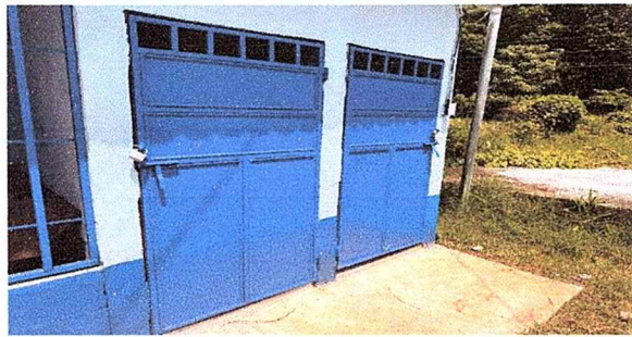
Foto 3: SE OBSERVA QUE LOS MÓDULOS DE SERVICIOS SANITARIOS YA CUENTA CON BANQUETA Y SE BRINDO MANTENIMIENTO A LOS MUROS EXTERIORES.
