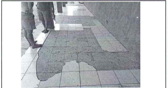
Foto 14: Se observa el piso cerámico en mal estado, se necesita sustituirlo
