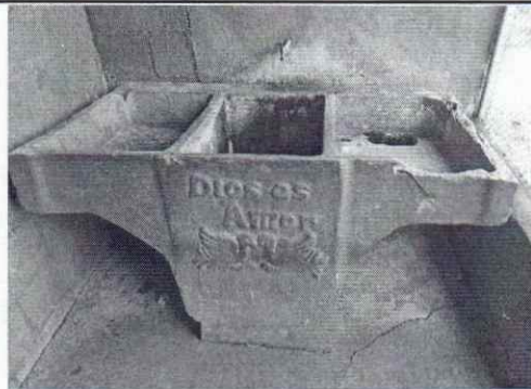
Foto 5: Se observa el mal estado de la pila y el piso y muro necesitan mejoras
