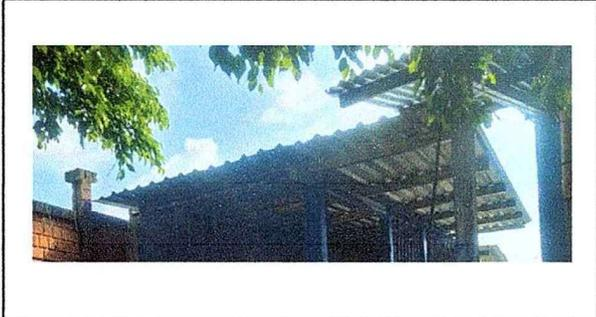
Foto 7: Finalización del cambio de lámina.
