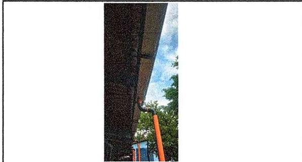
Foto 19: Finalización del cambio de canales de agua pluvial
