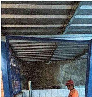
Foto 7: En proceso el cambio de lámina.
