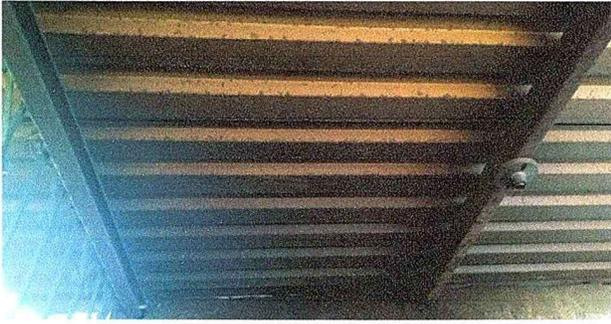
Foto 7: Se observa lámina deteriorada y mal estado
