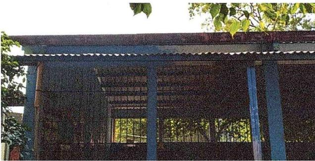
Foto 15: Se observa canal en mal estado
