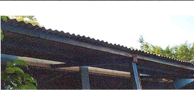
Foto 17: Se observa lámina en mal estado
