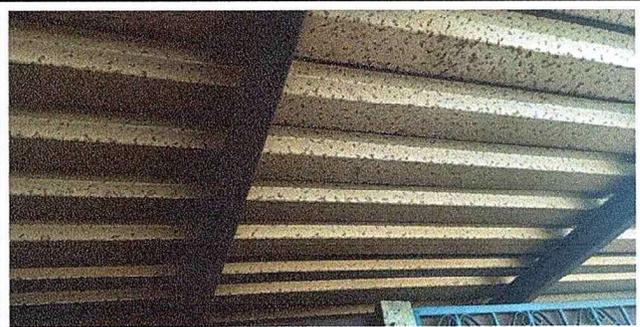
Foto 6: Se observa estructura de metal en mal estado
