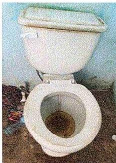
Foto 11: Se observan inodoros en mal estado con rajaduras y fugas de agua
