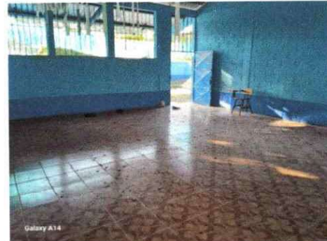
Foto 4: Se observa que se colocó piso cerámico en las aulas.
