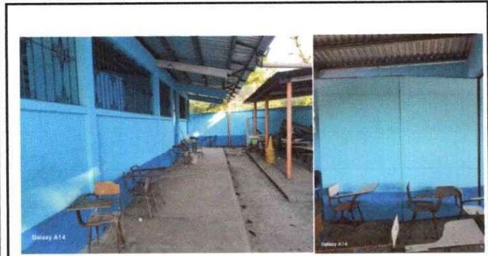
Foto 7: Se pintaron las paredes interiores y exteriores de las aulas.
