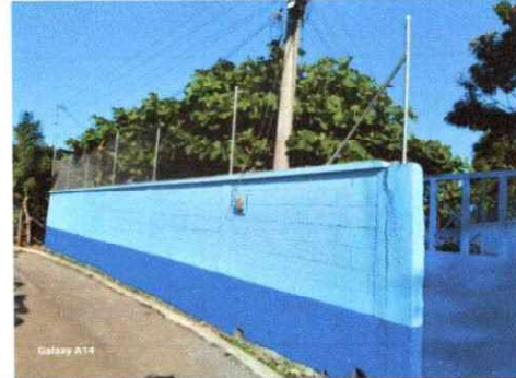
Foto 2: Se observa que se pintó las paredes del muro perimtral interna y externamente.
