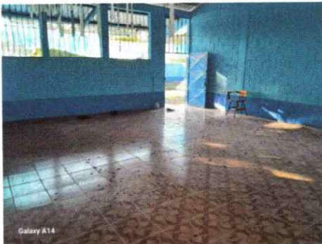
Foto 3: Se reparó el piso para la colocación de piso cerámico
