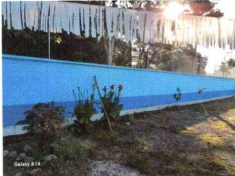
Foto 1: se observa que se instalo la malla sobre el muro perimetral.
