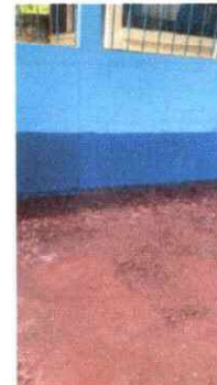
Foto 4: Se observa que se está preparando el piso para la colocación de piso cerámico.
