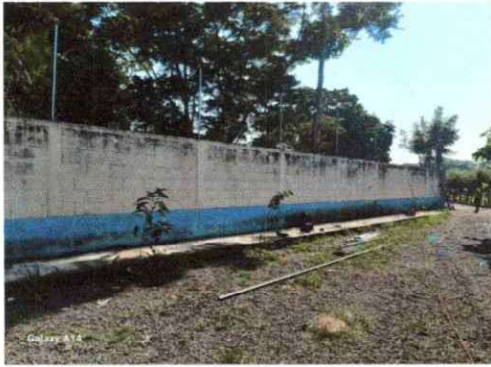
Foto 1: Se observa que se inició con la colocación de postes para colocar la malla.
