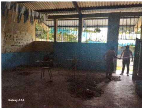
Foto 3: Se observa que se inició con la reparación del piso.
