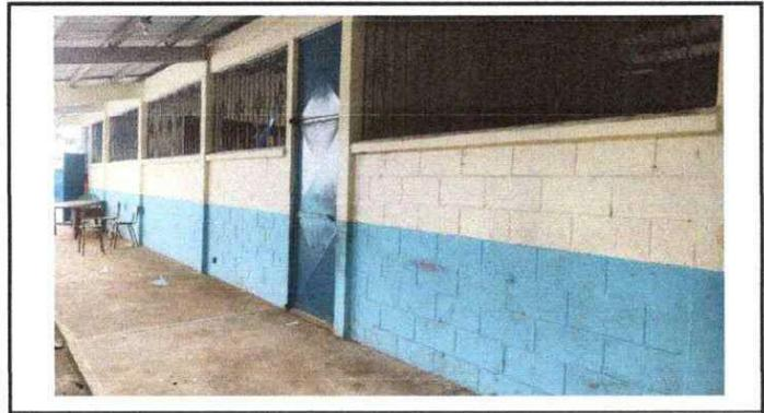
Foto 7: Se observa que por el estado actual de las paredes, es necesario aplicar pintura y resanas en donde es necesario.
