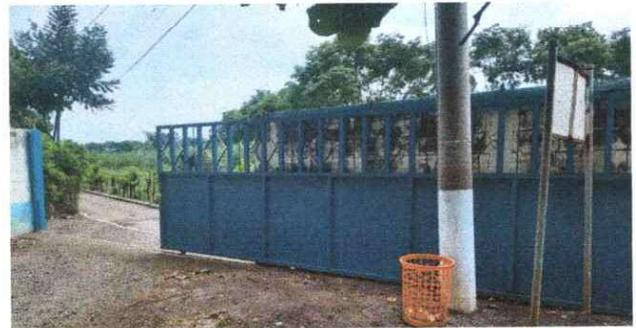
Foto 6: Se necesita darle mantenimiento al portón debido a su deterioro, sobre todo en su mecanismo de rodos.
