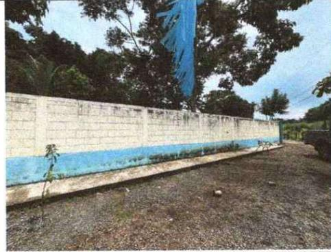
Foto 2: Se observa el deterioro en la pintura y estado general del muro perimetral, por lo que es necesario la aplicación de pintura.
