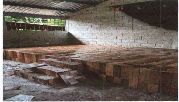
Foto 2: Se Observa el piso que a sido cambiado correctamente
