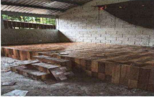
Foto 1: Se observa que el piso a estado colocandose
