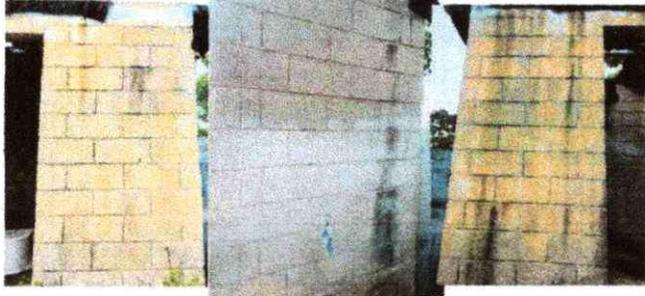
Foto 7. Se Observa paredes en mal estado por lo que se necesita repellar las paredes
