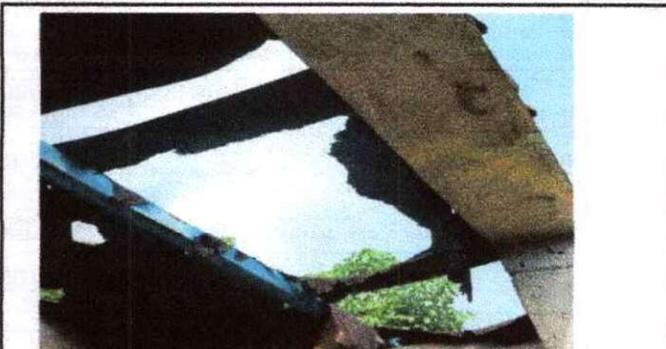
Foto 1. Se Observa el techo en mal estado es necesario sustituir la Estructura metálica y la lamina
