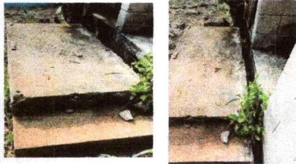
Foto 10. Se observan la necesidad de reparación de las torta de cemento
