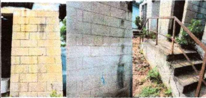
Foto 9. Se Observa la necesidad de aplicación de pintura en las paredes exteriores de los baños para una mejora en los mismos
