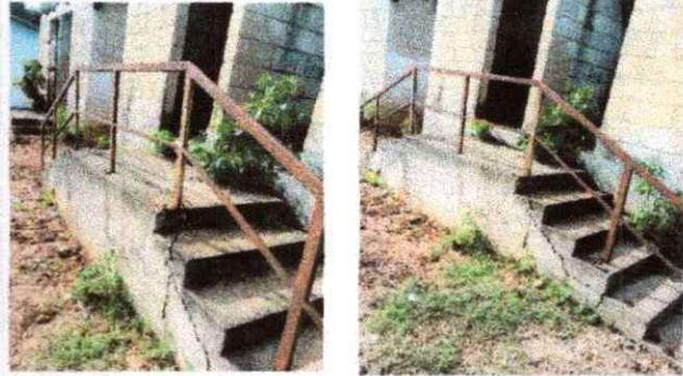
Foto 8. Se observa el deterioro de los barandales por lo cual se necesita cambio
