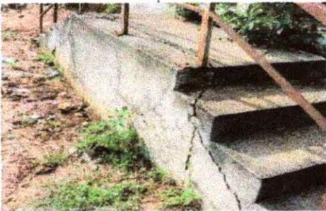
Foto 11. Se Observa la necesidad de reparación de las gradas para evitar que arruinen por completo
