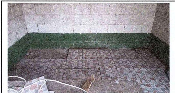
Foto 3: SE OBSERVA EL PROCESO DE LA INSTALACIÓN DEL PISO CERÁMICO ANTIDESLIZANTE.
