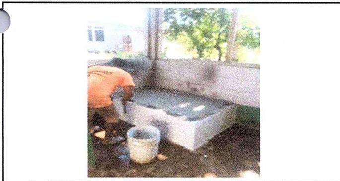
Foto 5: SE OBSERVA EL PROCESO DE CONSTRUCCIÓN DE ESTUFA ARTESANAL.
