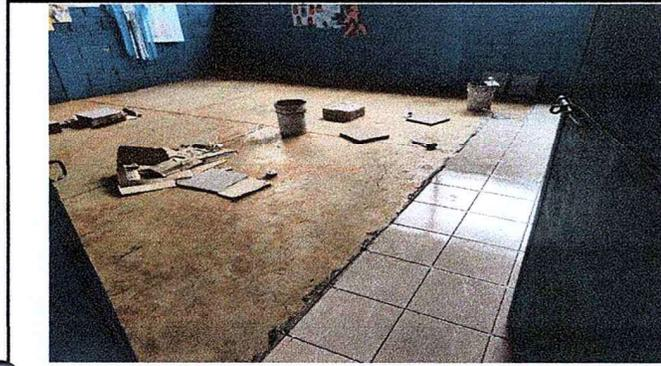
Foto 7: SE OBSERVA EL PROCESO DE INSTALACIÓN DE PISO CERÁMICO.
