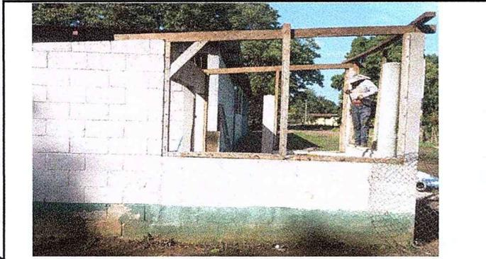
Foto 1: SE OBSERVA EL PROCESO DE CAMBIO DE ESTRUCTURA DE MADERA POR METAL.
