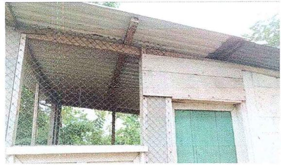
Foto 2: Las láminas se encuentran deterioradas.
