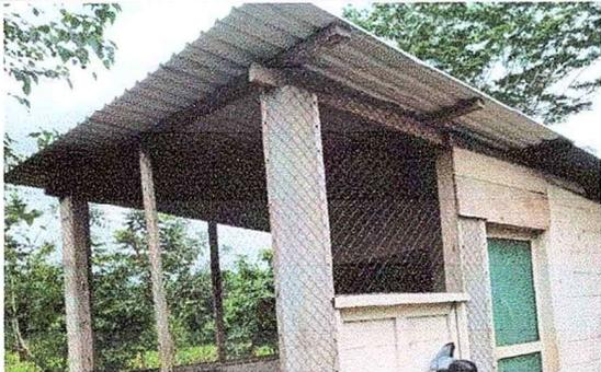
Foto 1: Se observa estructura de madera deteriorada.
