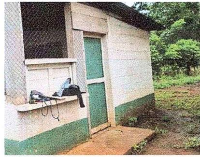
Foto 6: Se observa puerta en mal estado.
