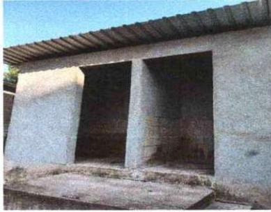
Foto 1. Se observa que la estructura de baño esta repellada
