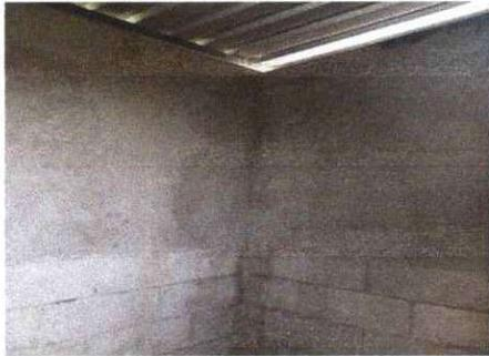
Foto 3. Se observa que las paredes del sanitario fueron repelladas
