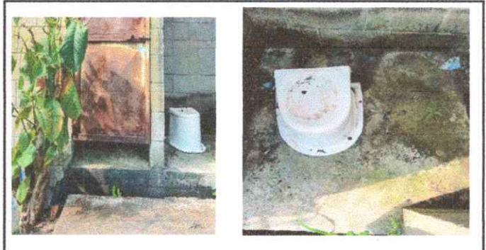
Foto 6. Observa que le servicio sanitario ya no esta en condiones adecuadas y el piso necesita la sustitución a piso ceramico ya que no es higienico el que se observa.
