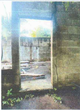
Foto 3: Se observa el bano de la puerta de cocina donde se necesita colocar puerta.
