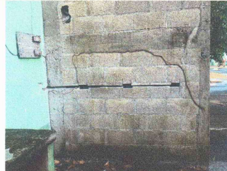
Foto 8: Se observa el área donde debe instalarse y suministrarse la electricidad.
