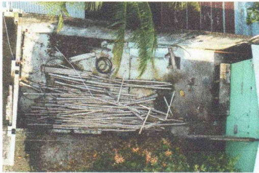
Foto 1: Se observa en vista de planta el espacio delimitado para el techado de lámina de cocina.
