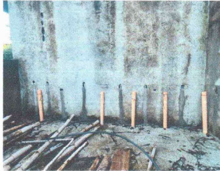
Foto 7: Se observa el espacio donde se colocarán los grifos de agua.
