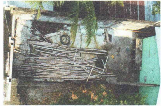
Foto 2: Se observa en vista de planta el espacio delimitado para la colocación de estructura de soporte de metal.
