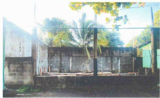
Foto 4: Se observan los banos de ventanas donde se necesita colocar balcones.
