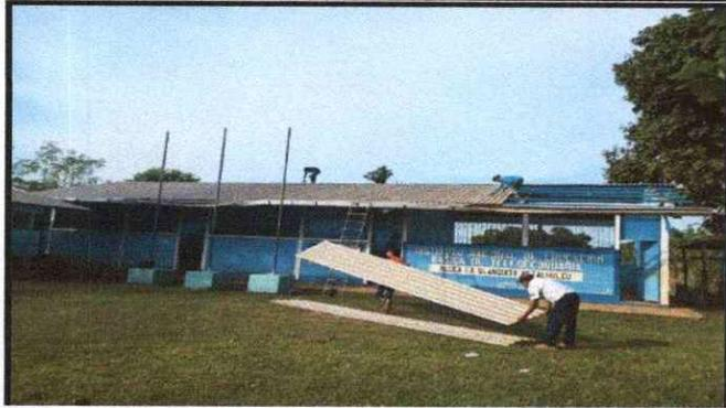
Foto1: SE OBSERVA QUE LAS LAMINAS TROQUELADAS SE ESTAN COLOCANDO EN LAS AULAS PRIORIZADAS.
