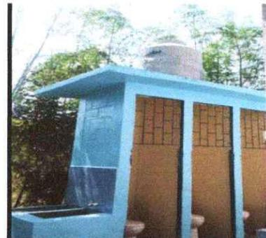
Foto 6: SE OBSERVA QUE EL DEPÓSITO DE AGUA DE 1100 LT, ES ESTA COLOCANDO.
