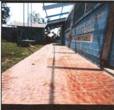
Foto 3: SE OBSERVA QUE EL PISO CERAMICO SE ESTA COLOCNADO EN EL AREA PRIORIZADA.
