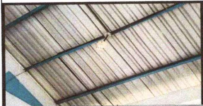
Foto 1: SE OBSERVA QUE EL TECHADO DE LAMINA TROQUELA TIENE FILTRACION DE AGUA, POR LO QUE ES NECESARIO LA SUSTITUCION POR LAMINA ALUZINC CALIBRE 26.
