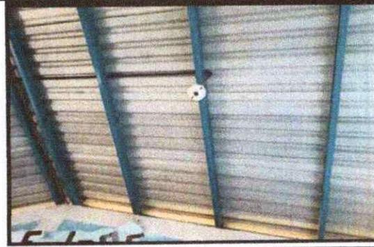
Foto 2: SE OBSERVA QUE SE REQUIERE LA REPARACIÓN DEL SISTEMA ELÉCTRICO, NO SE CUENTA CON LOS FOCOS POR LO QUE SE REQUIERE SU COLOCACIÓN.
