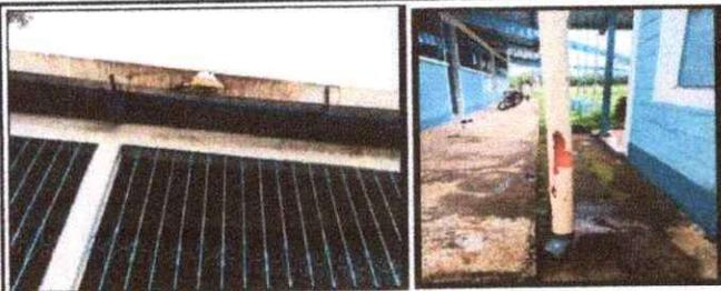
Foto 5: SE OBSERVA QUE ES IMPORTANTE LA SUSTITUCION DEL CANAL DE PVC Y BAJADAS DE AGUA, POR METAL.
