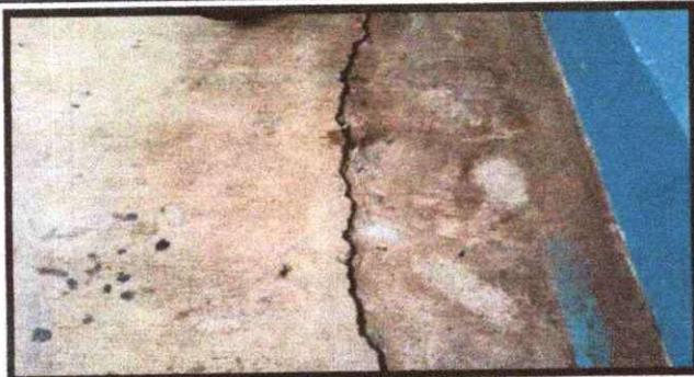
Foto 3: SE OBSERVA QUE EL PISO DE CEMENTO ESTA EN MAL ESTADO POR LO QUE SE NECESITA LA SUSTITUCION POR PISO CERAMICO ES URGENTE.
