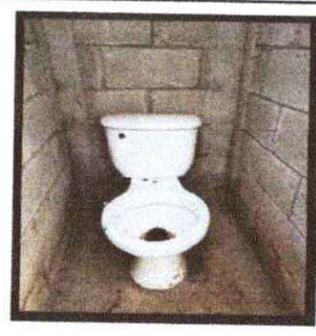
Foto 8: SE OBSERVA QUE EL INODORO ESTA EN MAL ESTADO POR LO QUE ES NECESARIO LA SUSTITUCION.
