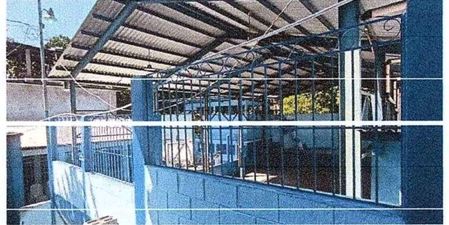
Foto 8: Se observa que se realizó la sustitución de malla por baranda de metal.
