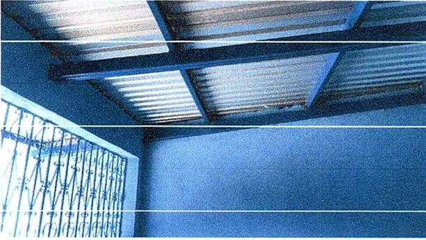
Foto 1: Se observa que se sustituyó lámina por lámina troquelada calibre 26.
