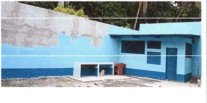
Foto 6: Se observa que se está aplicando pintura latex acrílica en muros exteriores e interiores.
