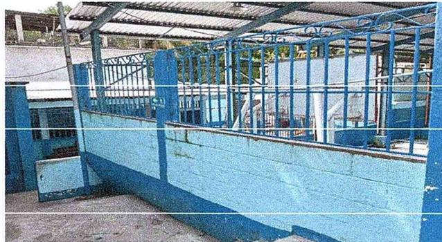
Foto 8: Se observa que se está realizando la sustitución de malla por baranda de metal.
