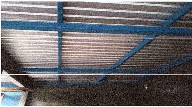
Foto 1: Se observa que se está sustituyendo lámina por lámina troquelada calibre 26.
