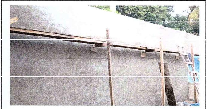
Foto 14: Se observa que se está repellando el muro y sellando las grietas y fisuras.
