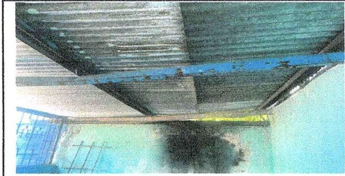
Foto 1: Se observa que se necesita sustitución de lámina por lámina troquelada calibre 26.
