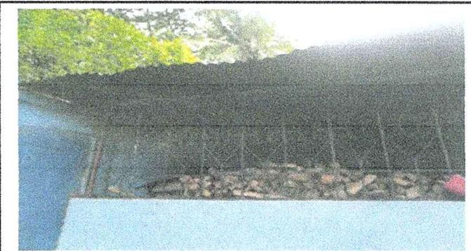
Foto 4: Se observa que se necesita sustitución de balcones de metal.
