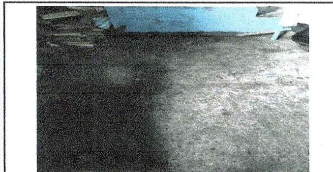
Foto 5: Se observa que se necesita realizar sustitución de torta de concreto por piso cerámico.
