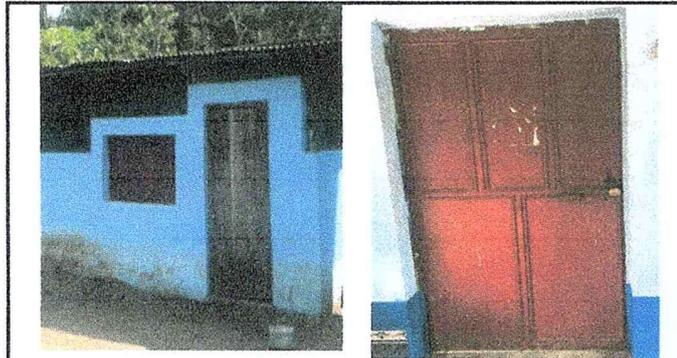
Foto 3: Se observa que se necesita urgentemente sustitución de puertas
