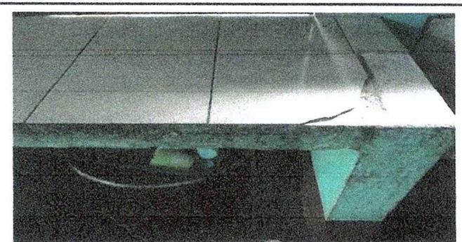
Foto 12: Se observa que se necesita reparación de azulejos en mueble de cocina
