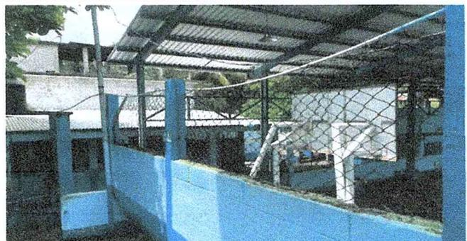
Foto 8: Se observa que se necesita realizar la sustitución de malla por baranda de metal.
