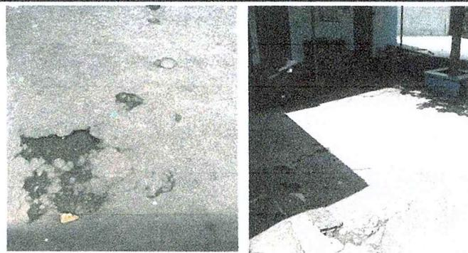
Foto 10: Se observan que se necesita reparación en plancha de concreto en patio.
