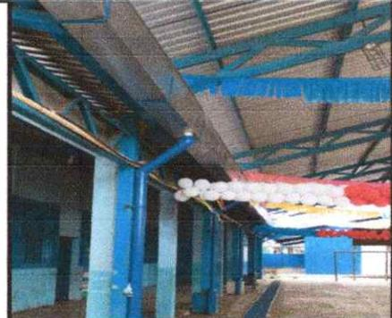
Foto 6: Sse observa que el canal de metal se esta colocando con sus bajadas de agua.
