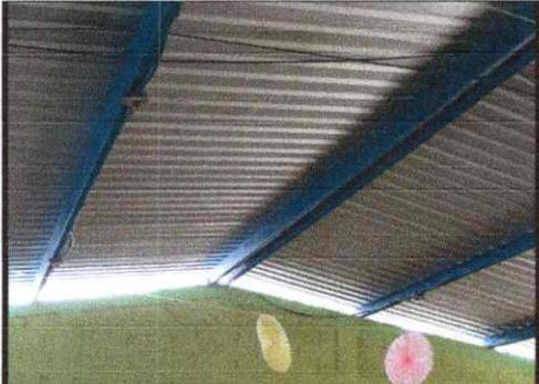
Foto 1: Se observa que se esta sustituyendo con lamina troquelada aluzinc 26
