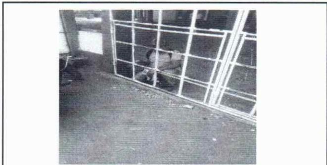
Foto 8: se Observa que le porton de acceso al establecimiento se encuentra en mal estado se requiere la sustitucion del mismo.
