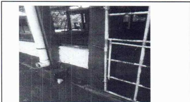
Foto 9: Se observa que la columna se encuentra condaños por falta de mantenimiento, es urgente el cambio.
