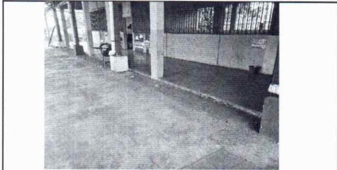
Foto 7: Es necesario realizar una cuneta de concreto para el desfogue del agua pluvial ya que inunda el acceso al establecimiento educativo.
