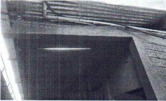
Foto 1 - Se observa que la lamina esta en mal estado tiene filtracion de agua, urge la sustitucion.
