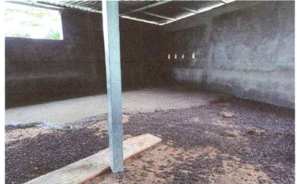
Foto 2: Se observa el trabajo de tirado de la plancha de cemento.
