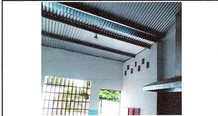
Foto 9 : Se observa la finalización de cambio de la estructura a metal.
