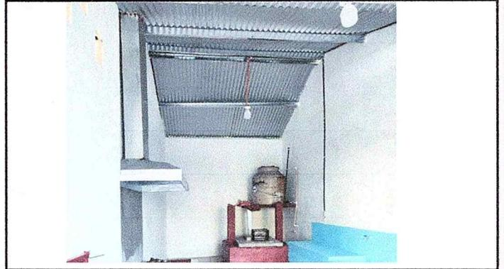
Foto 8 : Se observa la finalización de cambio de la lámina a lámina troquelada calibre 26 aluzinc.
