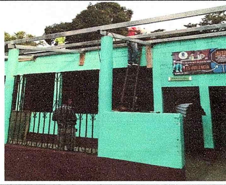
Foto 2: Se observa el proceso de cambio de la estructura de madera a metal.
