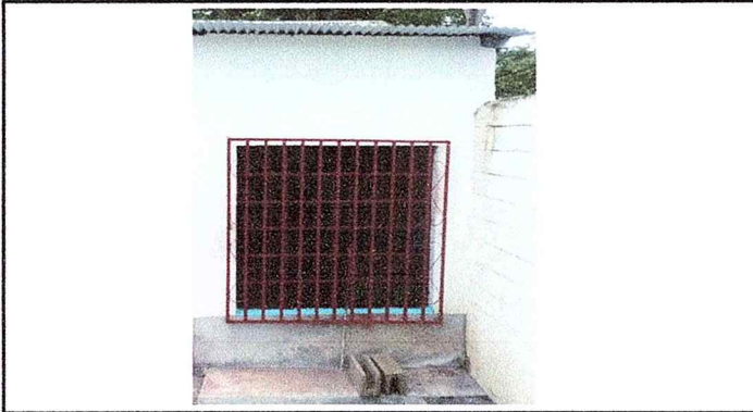
Foto 7 : Se observa el proceso de cambio del balcón de metal.
