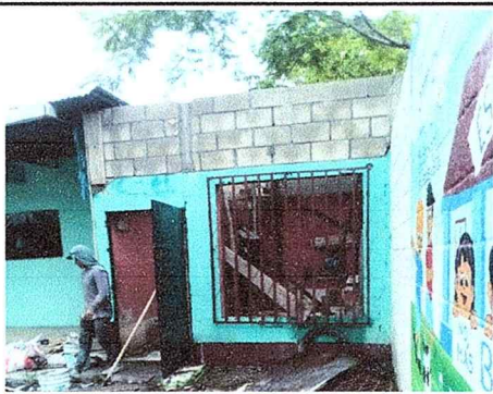
Foto 5 : Se observa el proceso de conformación y nivelación de la pared.
