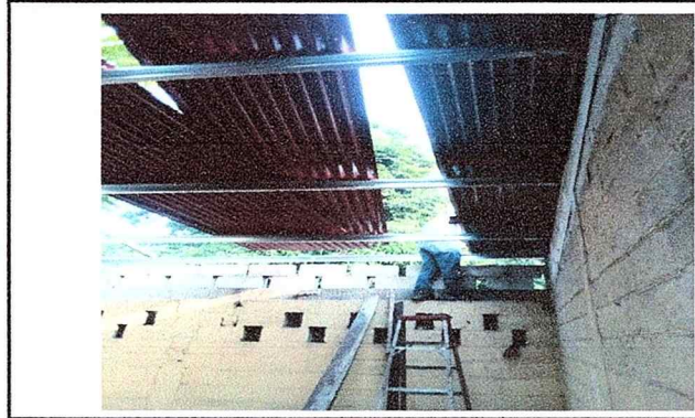
Foto 8 : Se observa el proceso de cambio de la lámina a lámina troquelada calibre 26 aluzinc.
