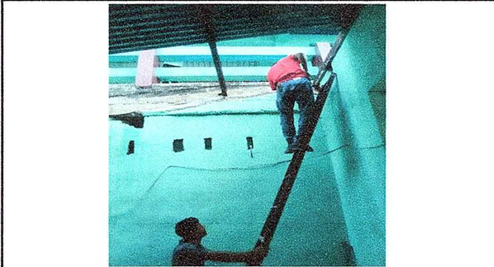
Foto 9 : Se observa el proceso de cambio de la estructura a metal.
