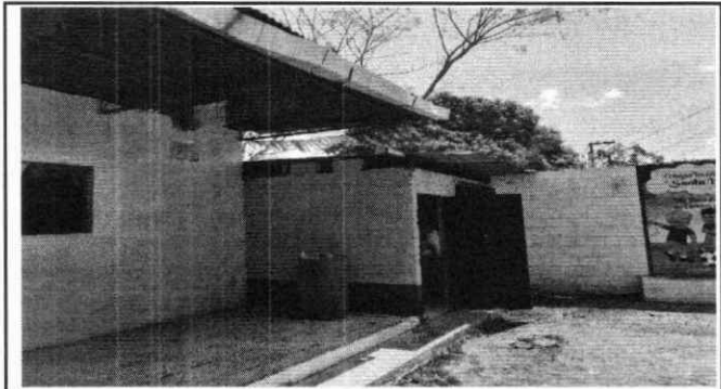
Foto 9: se Observa que la esctructura metal se encuentra deteriorada , por lo que es neceserio sustituirlo por soprte de metal.
