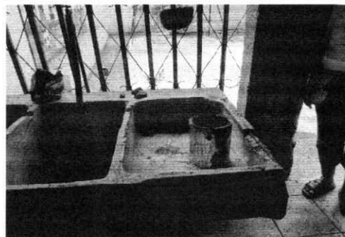
Foto 6: Se observa que la pila se encuentra en malas condiciones, por lo que urge su sustitución.
