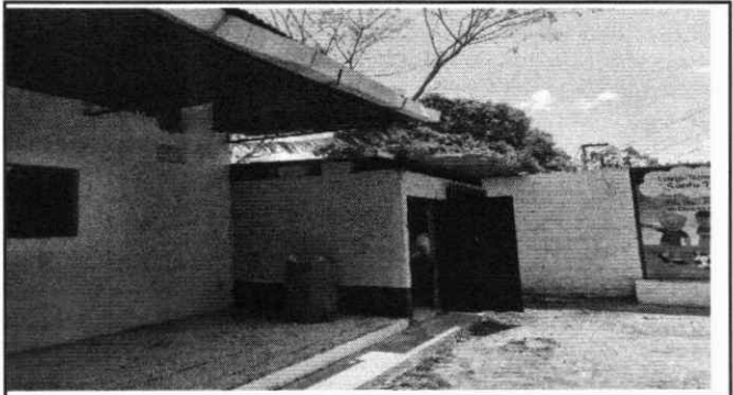
Foto 8: Se observa que la lamina se encuentra en mal estado , urge su cambio por lamian troquela calibre 26 aluzinc
