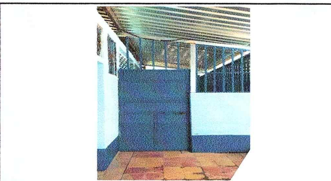
Foto 4: SE OBSERVA MANTENIMIENTO DE MURO BODEGA EN BUEN ESTADO.
