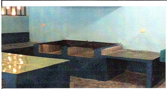
Foto7: SE OBSERVA ESTUFA DE LEÑA NUEVA Y EN BUEN ESTADO, ASÍ COMO BANCO DE TRABAJO DE CONCRETO Y AZULEJO.
