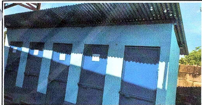
Foto 9: SE OBSERVA MANTENIMIENTO PREVENTIVO DE LOS MUROS EXTERIORES DE LAS LETRINAS.
