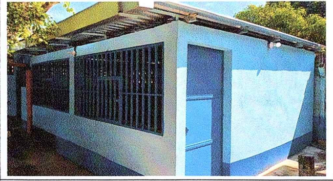
Foto 2: SE OBSERVA EL MEJORAMIENTO DE LA COCINA, CON LA CONFORMACIÓN DE MURO, BALCONES Y PUERTA.
