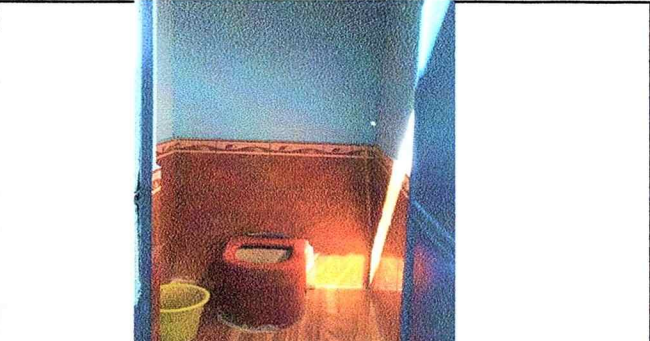
Foto 10: SE OBSERVA SUSTITUCIÓN DE LETRINAS. ASÍMISMO PROTECCIÓN DE MUROS A TRAVÉS DE LA INSTALACIÓN DE AZULEJO Y PINTURA Y MEJORAMIENTO DEL PISO.
