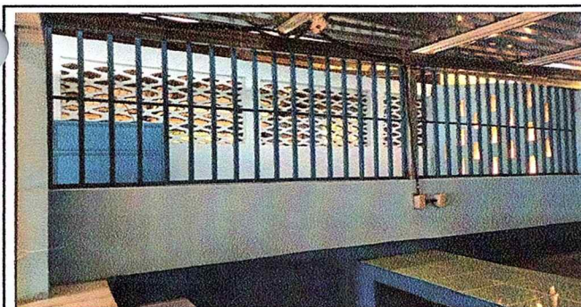
Foto 3: SE OBSERVAN LAS VENTANAS CON BALCONES NUEVOS EN BUEN ESTADO.
