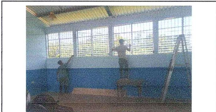
Foto 15: Se observa la instalación de ventanas de metal mas vidrio en las aulas donde se entra agua
