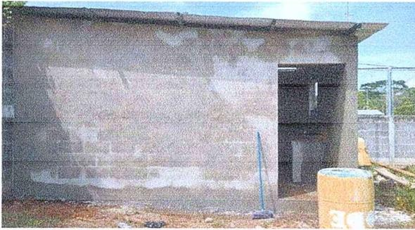
Foto 1: Se observa las paredes proceso de repello
