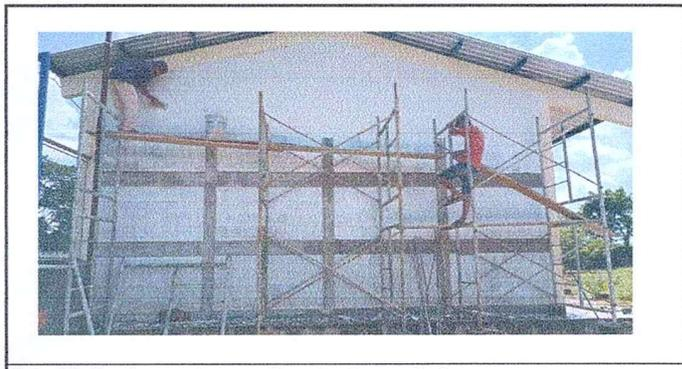
Foto 12: Se observa las paredes siendo repelladas
