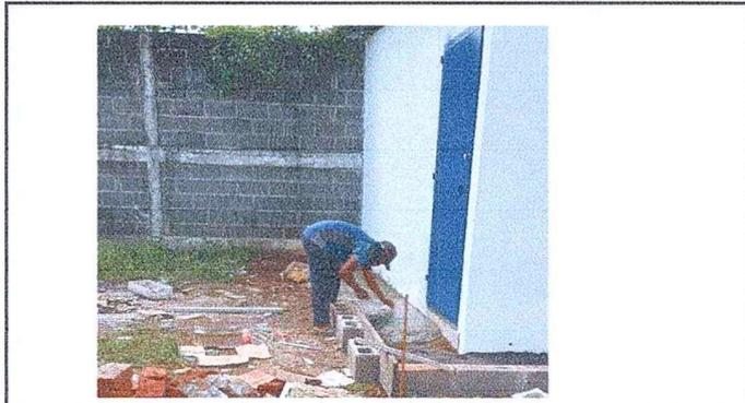
Foto 8: Se observa fundicion manual banqueta de concreto
