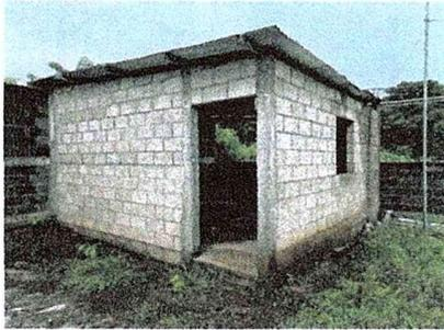
Foto 1: Se observa que la pared está de puro block y no tiene repello
