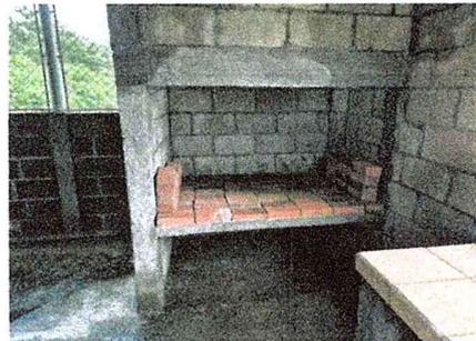
Foto 4: Se observa que la estufa no está funcional, no cuenta con ningún tipo de plancha ni el cubrimiento de ladrillo y la chimenea tiene filtración de agua cuando llueve.
