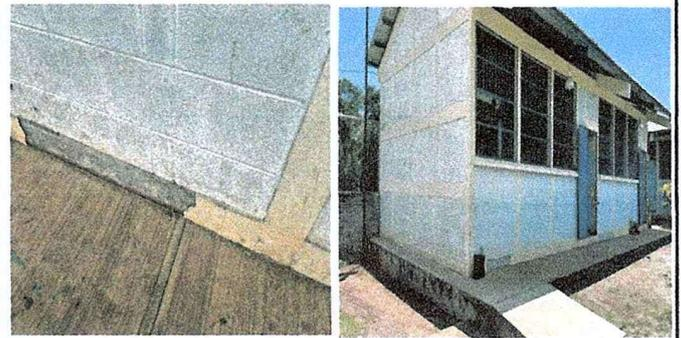
Foto 12: Se observa repello dañado en paredes de aulas
