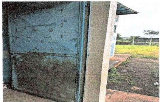
Foto 16: Se observa puerta con oxidación avanzada y falta de mantenimiento
