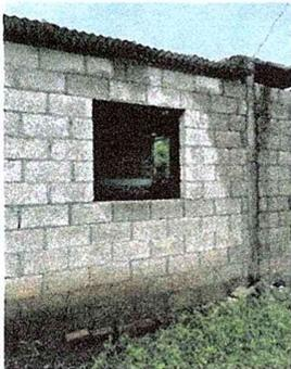
Foto 3: Se observa que las ventanas no tienen vidrio ni balcón de metal.
