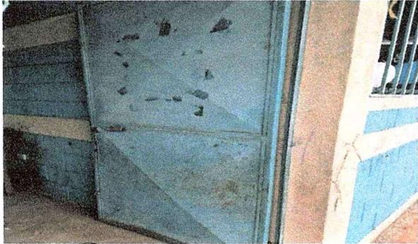
Foto 13: Se observan puertas de aulas con oxidación y falta de mantenimiento
