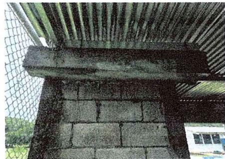
Foto 6: Se observa que el canal interior no tiene caída
