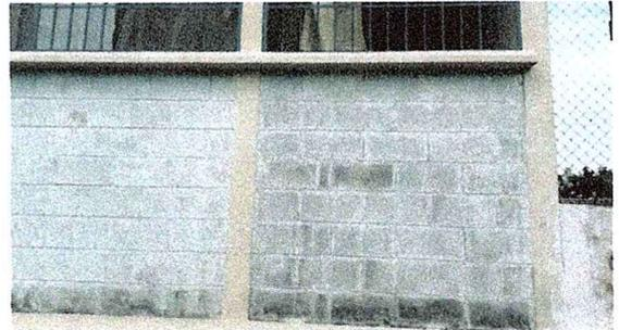
Foto 14: Se observa paredes de aulas tienen moho y pintura deteriorada
