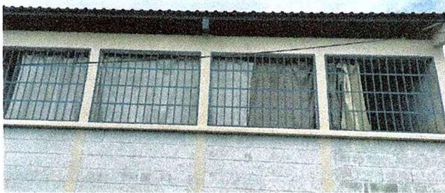
Foto 15: Se observa falta de ventanería en aulas que permiten el ingreso de agua
