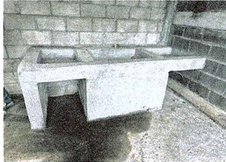
Foto 2: Se observa que las paredes no tienen aplicado cernido
