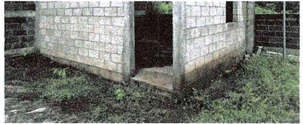
Foto 8: Se observa que el modulo no cuenta con banqueta de concreto
