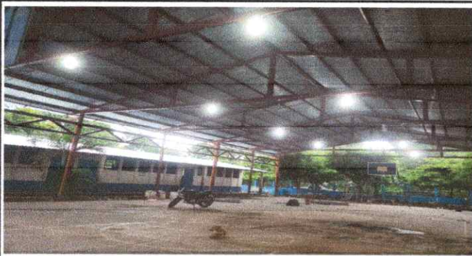
FOTO 15: CONEXIONES ELECTRICAS: DESPUES
