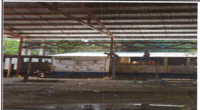
FOTO 14: CANALES DE METAL INSTALADOS: DESPUES
