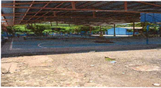
FOTO 13: MANTENIMIENTO DE ESTRUCTURA DE METAL : DESPUES
