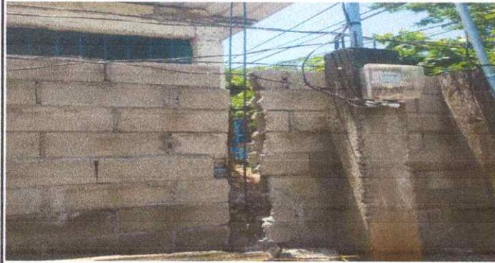
FOTO7: REPARACION DE MURO PERIMETRAL DURANTE
