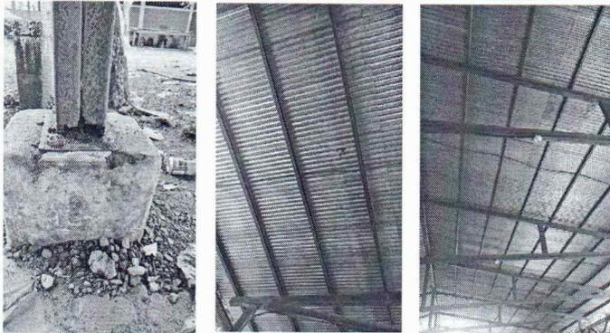
Foto 1: Se observa que la estructura de soporte de metal del techado de la cancha, necesita mantenimiento preventivo y correctivo
