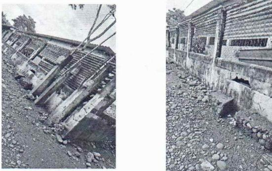
Foto 5: Se observa que el muro perimetral del Centro Educativo, necesita reparación.
