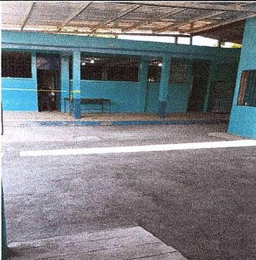
Foto 9: Se observa la finalización de la plancha de concreto en el Salón de usos múltiples.
