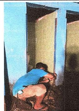
Foto 12: Se observa el proceso de sustitución de puerta de baños.
