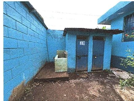
Foto 12: Se observa las puertas en mal estado y sus cerraduras en mal estado que complica la cerrada del mismo
