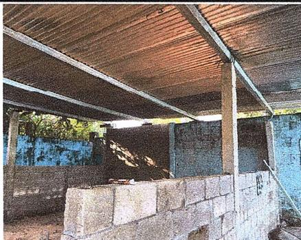
Foto 11: Se observa la falta de pintura en los muros interiores y exteriores
