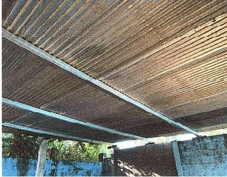
Foto 1: Se observa el mal estado en la lamina y cuenta con goteras internas
