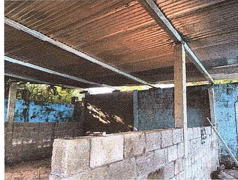
Foto 2: Se observa la falta de estructura metalica
