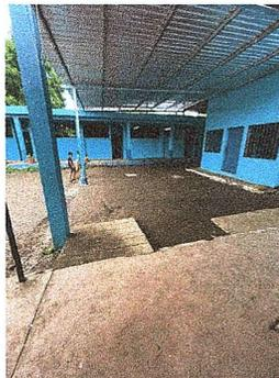
Foto 9: Se observa la falta de plancha de concreto en el salon de usos multiples
