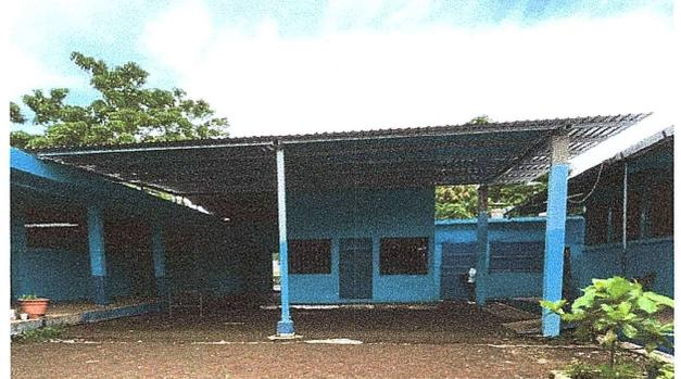
Foto 8: Se observa la falta de canal de agua, por el problema que la lluvia a comenzado a escarbar el area
