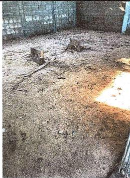
Foto 5: Se observa la falta de torta de concreto y seguido el piso ceramico
