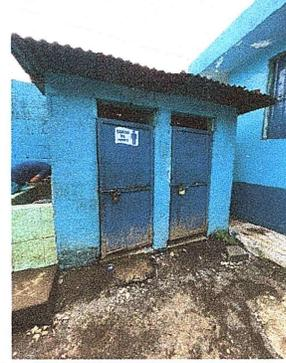
Foto 14: Se observa la lámina en mal estado
