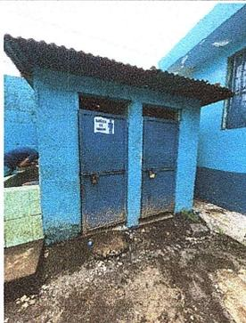
Foto 15: Se observa que la estructura es de madera y cuenta con polilla y es muy corta para el espacio que se requiere
