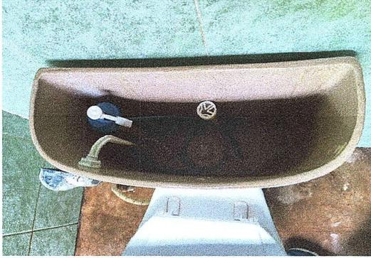
Foto 13: Se observa el mal estado de los componentes del inodoro y hace que el agua pase de largo
