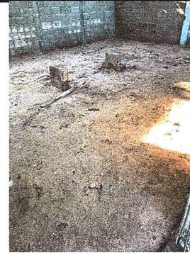
Foto 4: Se observa la falta de torta de concreto
