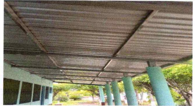
FOTO 2 : SE OBSERVA QUE LA LAMINA DE ZINC HA SIDO CAMBIADO EN SU TOTALIDAD DEL MODULO.
