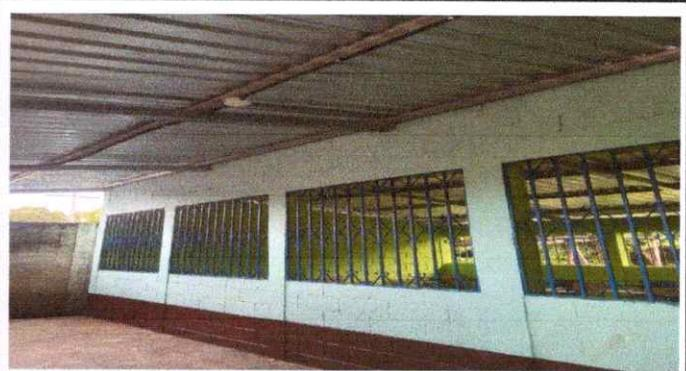
FOTO 4 : SE OBSERVA EL MODULO DE AULA COMO QUEDO POR AFUERA CON EL CAMBIO DE LAMINA Y PINTADA.
