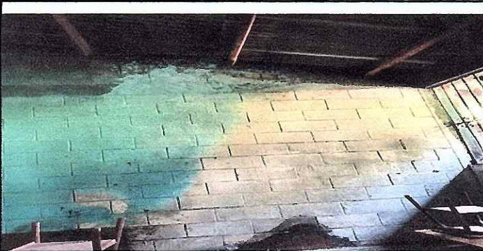
FOTO 5: SE OBSERVA QUE EL MÓDULO NECESITA REPELLO Y APLICACIÓN DE PINTURA.
