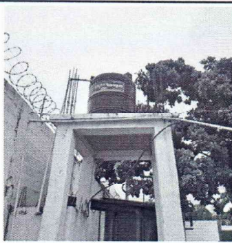
Foto 9: Se observa que el deposito de agua y la bomba, ya no funcionan, urge su sustitución
