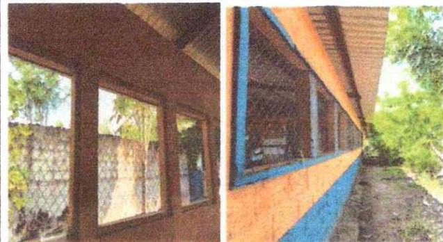
Foto 3: Se observa la necesidad de Sustitución de la malla por balcones de metal
