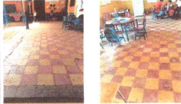
Foto 1: Se observa la necesidad de sustitución de piso cerámico por deterioro del que tiene el aula
