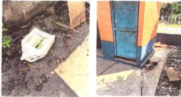
Foto 7: Se observa la necesidad de la sustitución el mingitorios por uno de concreto y azulejo, demas de la reparación de la plancha de cemento
