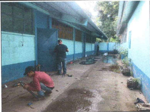
FOTO 3: SE OBSERVA QUE SE LE ESTA DANDO EL MANTENIMIENTO REQUERIDO A LAS PUERTA DE AULA.
