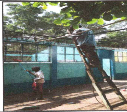
Foto 2: SE OBSERVA QUE SE LE ESTA DANDO EL MANTENIMIENTO A LAS COSTANERAS DE AULA.
