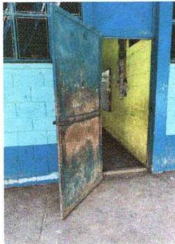
Foto 3: Se observa el daño en las puertas por óxido, por lo que requieren mantenimiento.
