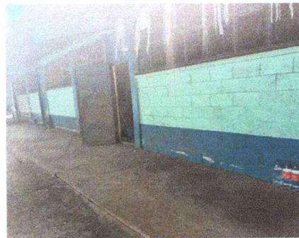
Foto 6: Se observa el deterioro de la pintura en muros exteriores por lo que es necesario pintar nuevamente.
