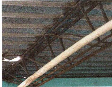
Foto 2: Se observa que la estructura metálica presenta deterioro por lo que es necesario darle mantenimiento.
