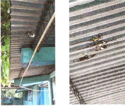
Foto 1: Se observa que la lámina se encuentra deteriorada, presenta agujeros por lo que es necesario sustituirla.
