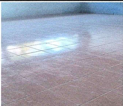
Foto 9: Se observa la finalización de los trabajos de piso.
