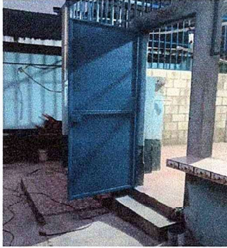
Foto 1: Se observa la finalización de los trabajos de la puerta.
