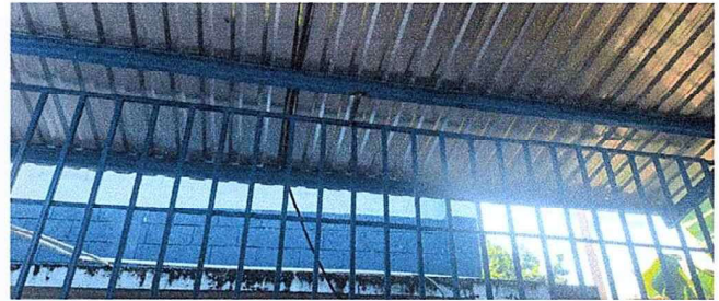
Foto 4: Se observa la finalización de los trabajos de balcones.
