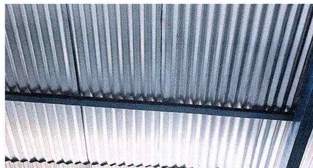
Foto 10: Se observa la finalización de los trabajos de láminas.
