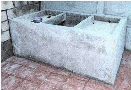
Foto 3: Se observa la finalización de los trabajos de la pila.
