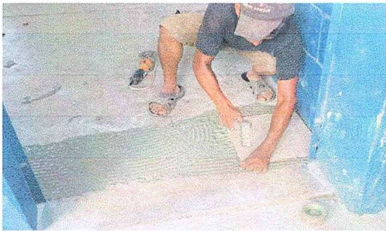
Foto 9: Se observa el proceso de los trabajos de piso.
