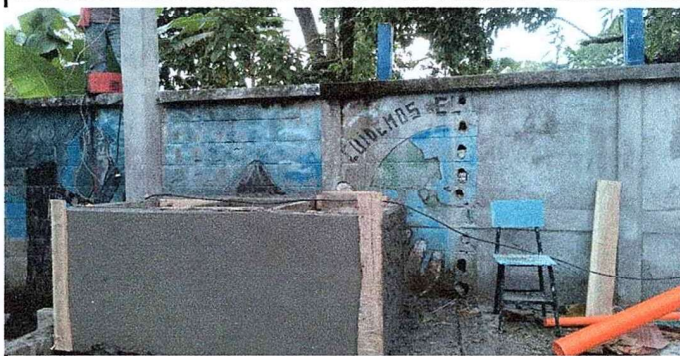
Foto 3: Se observa el proceso de los trabajos de la pila.
