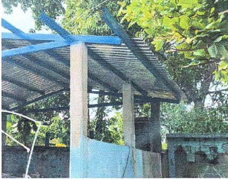
Foto 7: Se observa el proceso del trabajos de cambio de láminas.
