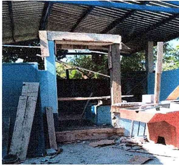
Foto 1: Se observa el proceso de los trabajos de puerta.
