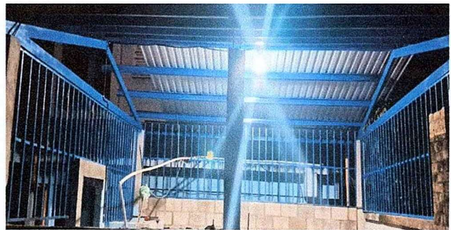
Foto 4: Se observa el proceso de los trabajos de balcones.
