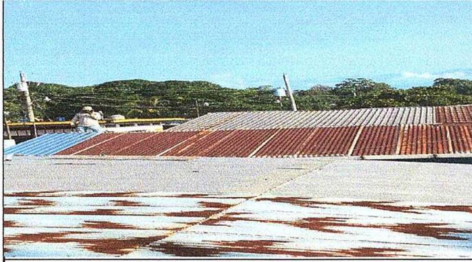
Foto 1: Se observa el proceso de instalacion de lámina troquelada.
