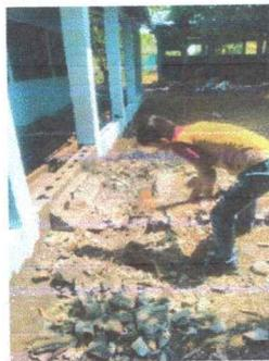
Foto 6: Se observa que los trabajos de cuneta para evacuar el agua de lluvia en época lluviosa se están ejecutando.
