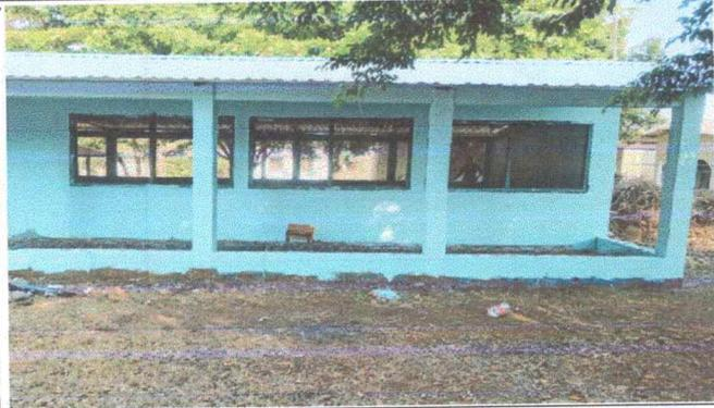
Foto 1: Se observa que el módulo de aulas No. 6 se está haciendo los trabajos de sustitución de la lámina troquelada calibre 26
