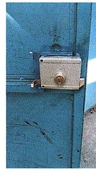
Foto 4: se observa chapa nueva instalada
