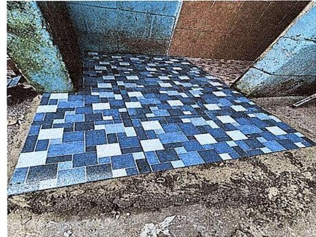
Foto 10: Se observa nivelación e instalación de piso en baños
