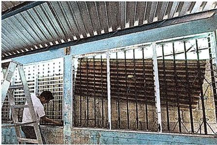
Foto 3: Se observa proceso de instalación de ventanas
